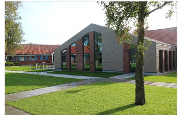
Neubau eines Seminar- und Gästehauses am Standort des Schullandheims der Region in Nieblum auf Föhr
